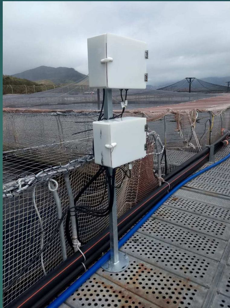
Poste Con cajas Emisoras
