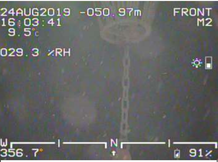
Se muestra estado de herrería y cadena de peso péndulo jaula 111.
