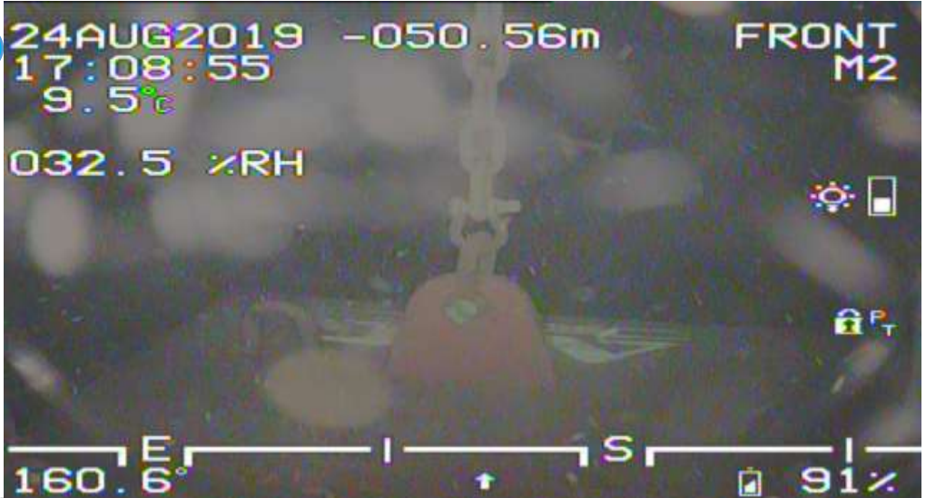
Se observa estado general de grilletes y peso péndulo inspeccionados.
