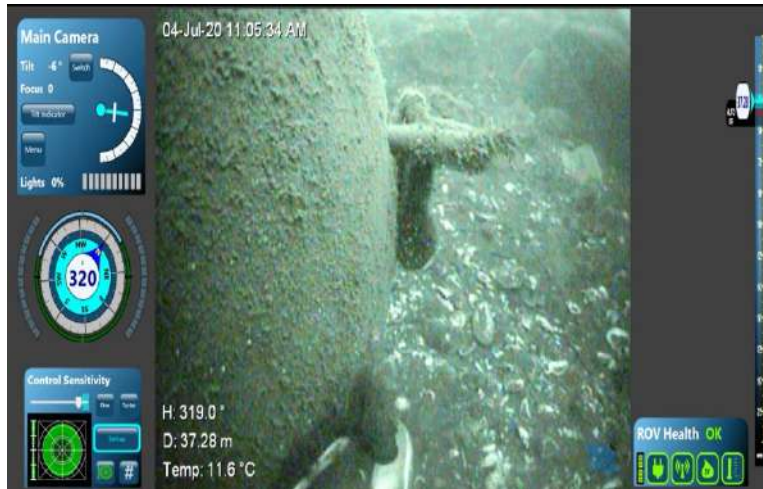
OBJETO: Contrapeso de 500kg PROFUNDIDAD: 37m AREA: Bajo central de posición de modulo
