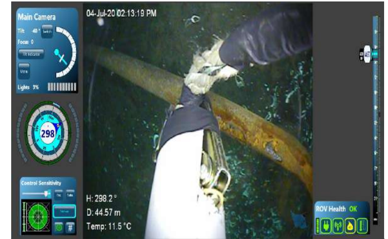
OBJETO: : Baranda de pasillo PROFUNDIDAD: 45m AREA: Bajo central de posición de modulo
