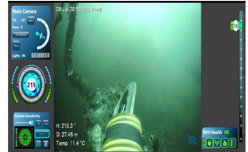
OBJETO: Tramo de cabo 30m PROFUNDIDAD: 28m AREA: Bajo central de posición de modulo
