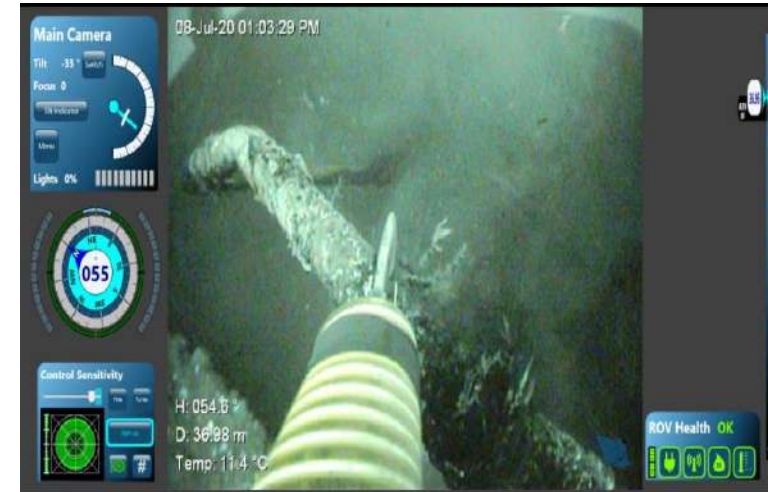
OBJETO: baranda de pasillo PROFUNDIDAD: 37m AREA: Bajo central de posición de modulo
